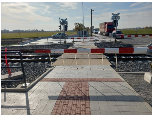
Železniční přechod zabezpečený přejezdovým zabezpečovacím zařízením světelným se závorami
