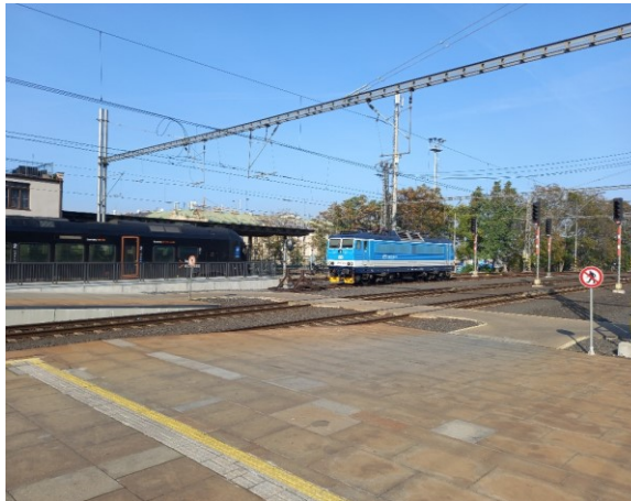
Přejezd pro vozíky navazující na šikmou plochu nástupiště
