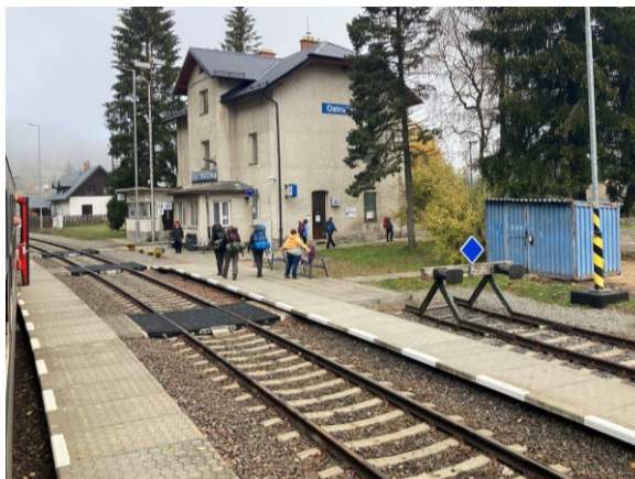
Úrovňový přechod přes nástupní hranu úrovňového nástupiště
