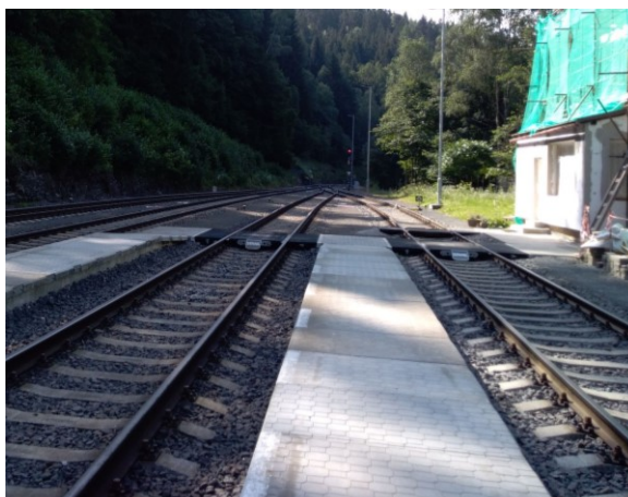
Úrovňový přechod z čela úrovňového nástupiště
