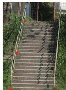
schody mimo budovy, vícestupňové, pevné
